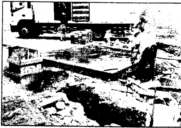
Foto N° 01 y 02: Vista de los Trabajos realizados en area de Patio de Maniobras, habilitación de acero y encofrado, corte perfilado de terreno, compactacion de base y sub base, vaciado en concreto.
