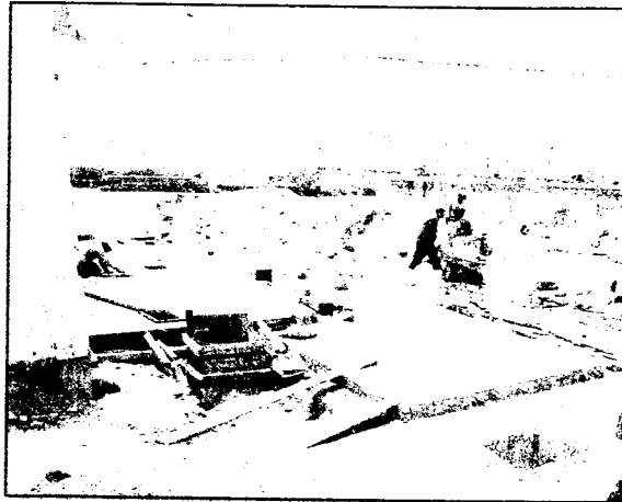
Foto N° 03 y 04: Vista de los Trabajos realizados en area de Patio de Maniobras, habilitación de acero y encofrado, compactacion de base y sub base, vaciado en concreto.
